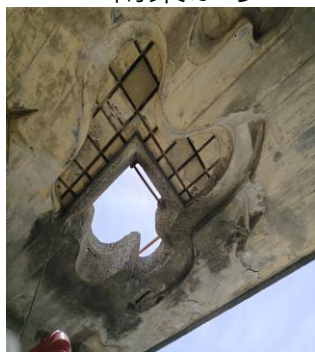
塔屋天井の装飾
