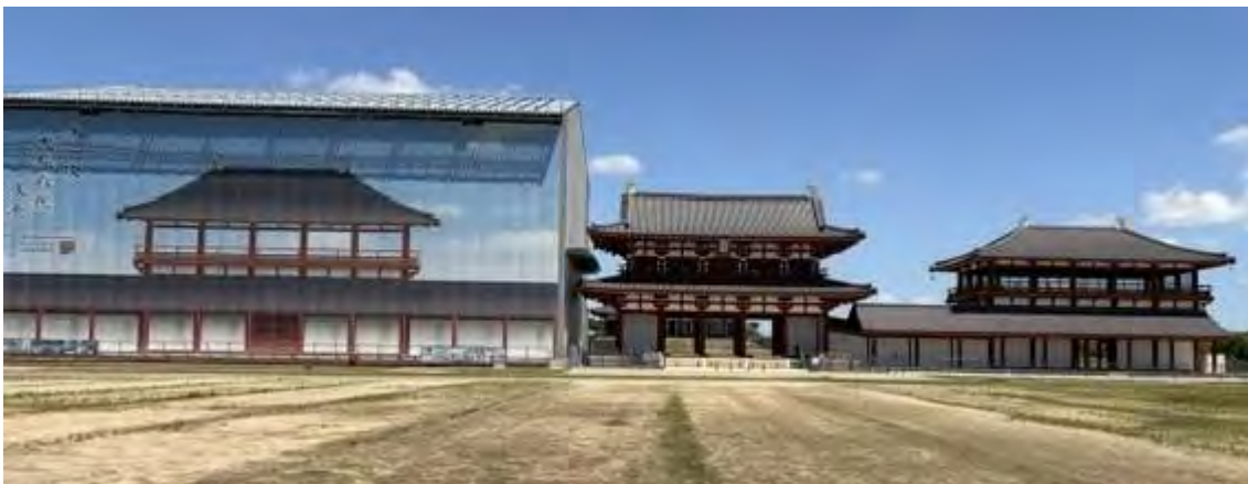
西楼 すやね 素屋根(工事用仮設建築物)
