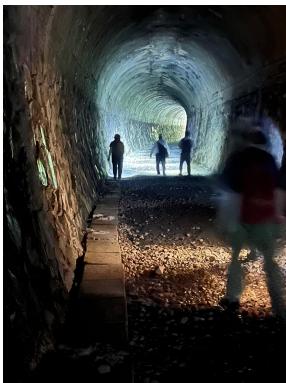
長尾山第一トンネル(306m)
