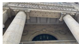
雨水を落とすための排水口
