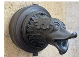
雨水を落とすための排水口
