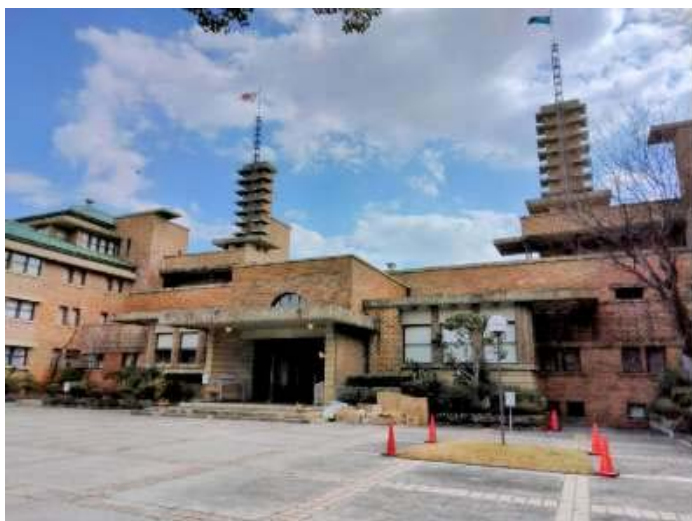
正面側建物外観
