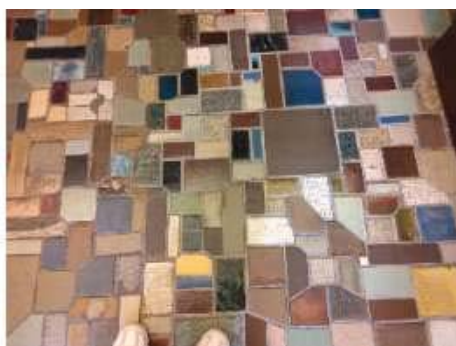
バー床面の泰山タイル
