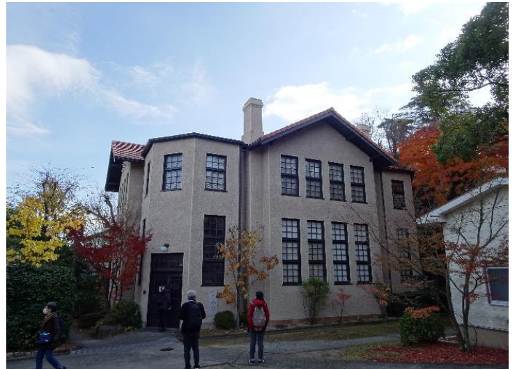
ハミル館 竣工：1918年（T7）に原田の森で建設後 1929年（S4）上ヶ原に移設 設計：W.M.ヴォーリス 木造2階建てモルタル外壁 赤面スレート葺
