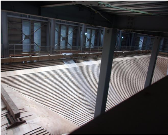
修理工事中の根本中堂
