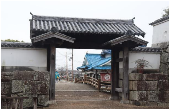
3 大手門内側（高麗門）
