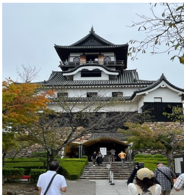
天守は日本最古の様式で望楼型天守と呼ばれ、地下2階地上4階建
