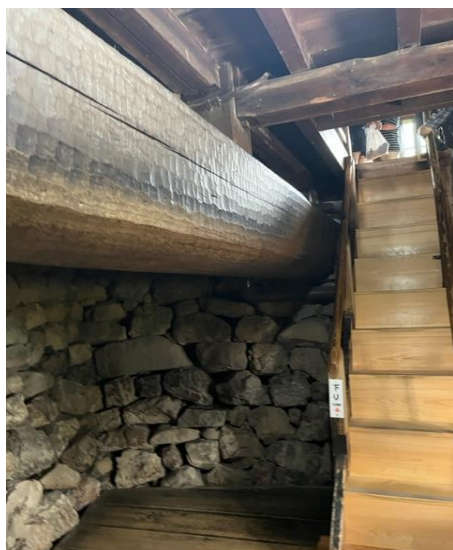
入城口(地下2階)より入った所、野面積の石垣、手斧で削った大きな梁、急な階段
