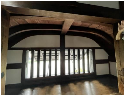
唐破風の間（天井が弓なり）
