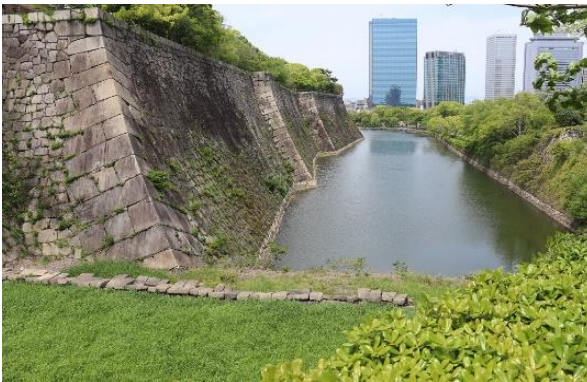
内堀と空堀の境界部
