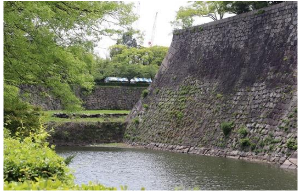
内堀と空堀の境界部
