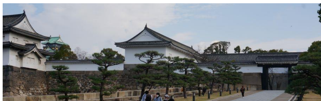
左から 千貫橋、多門橋、大手口土橋と大手門 すべて重要文化財
