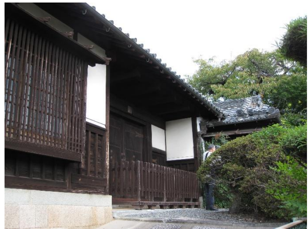
麻田藩陣屋門
